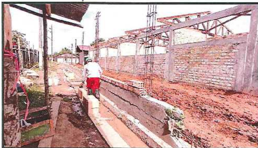
Asentado de ladrillo tipo sogá en cerco perimétrico
