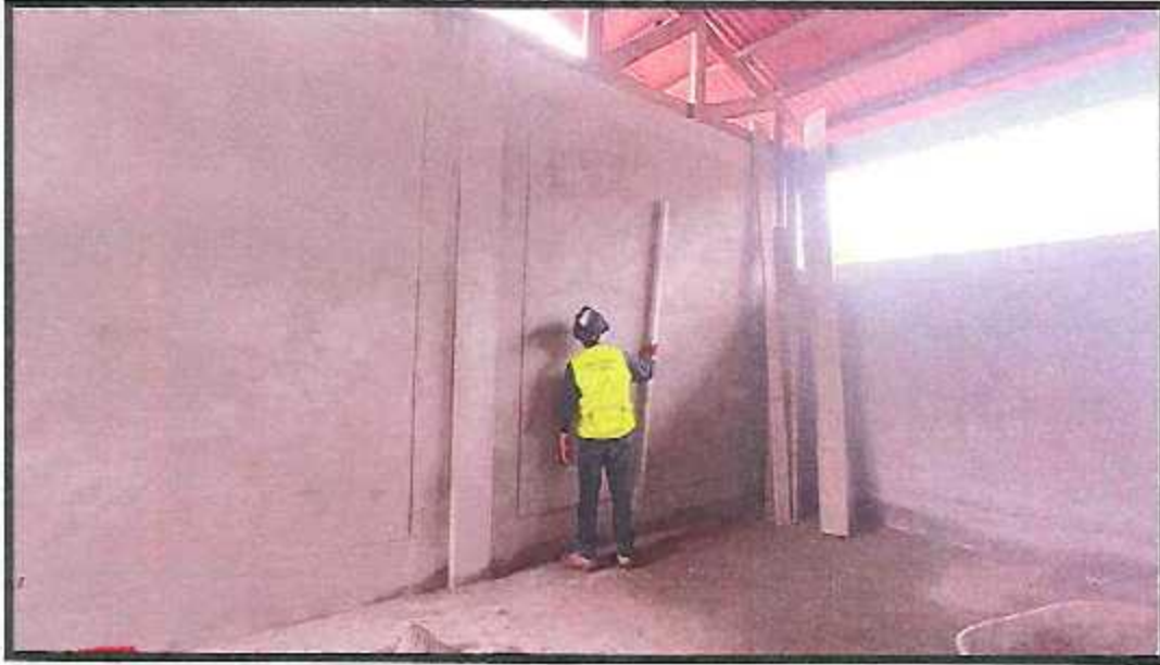
Verificación de tarrajeo interior en módulos
