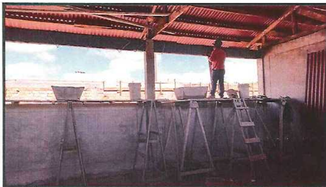
Tarrajeo en muro interior, derrame en vigas de módulos.
