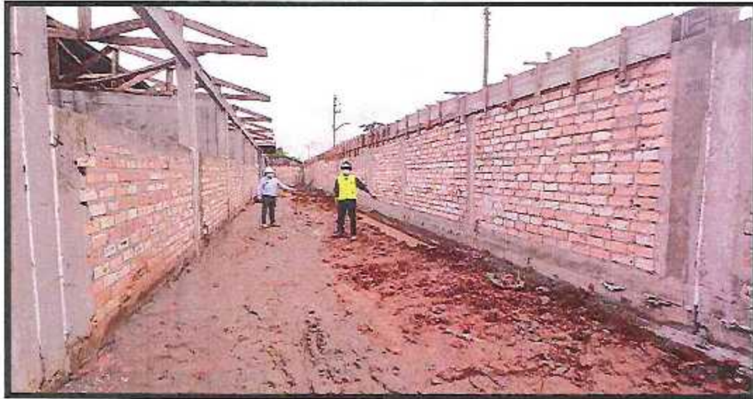
Muro de ladrillo tipo sogá en cerco perimetrico
