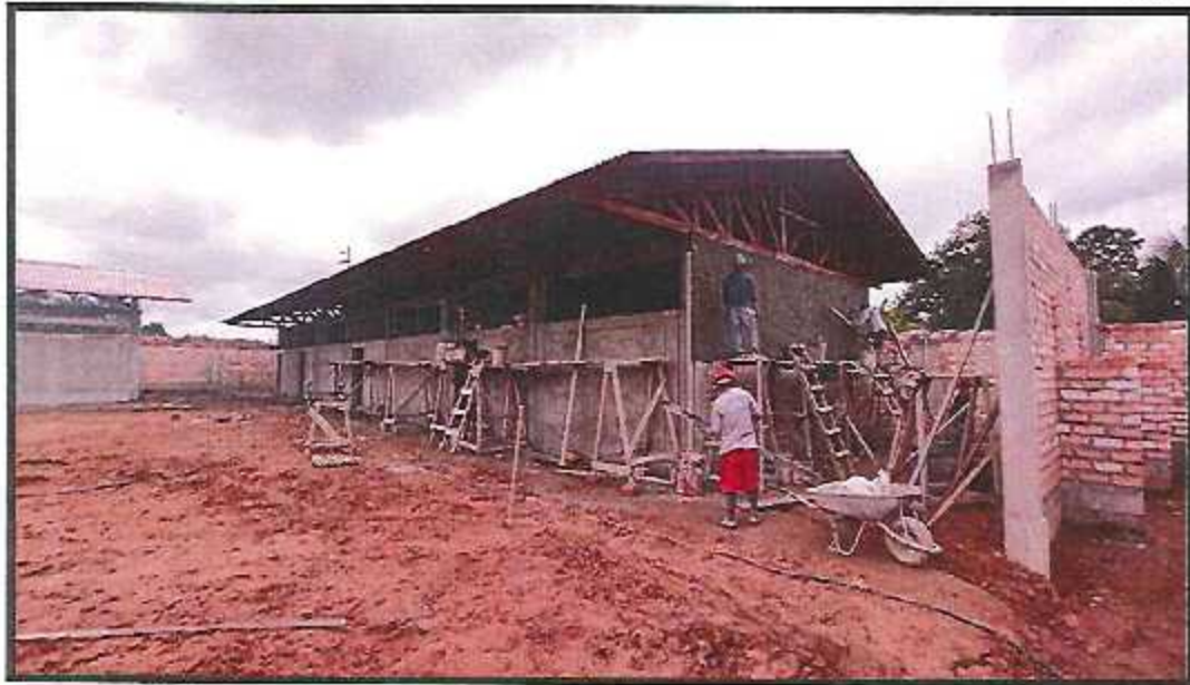
Tarrajeo en muro exterior, derrame en vigas de módulos.
