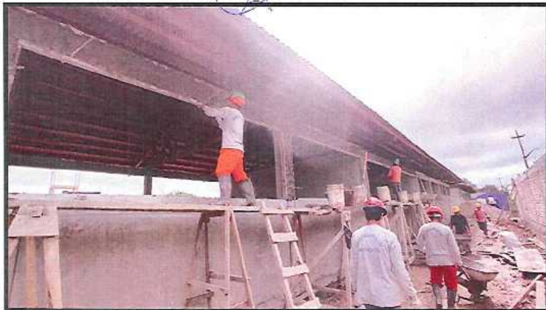
Tarrajeo en muro exterior, derrame en vigas de modulos.
