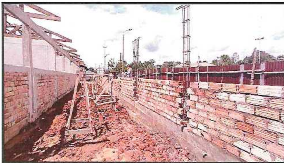
Muro de ladrillo tipo sogá en cerco perimétrico
