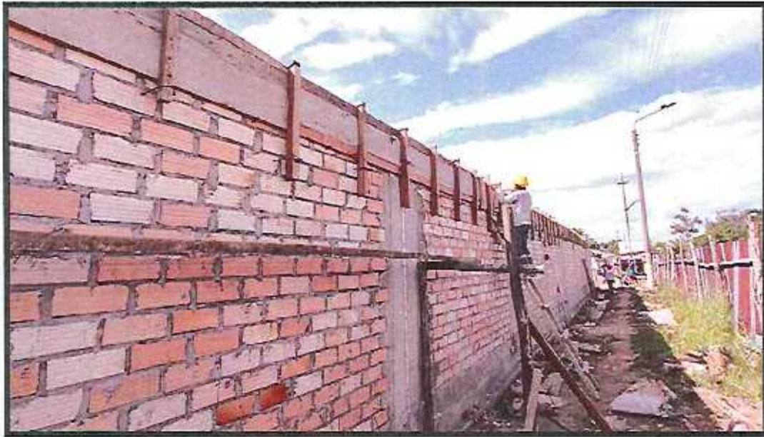
Viga de amarre en muro perimetrico
