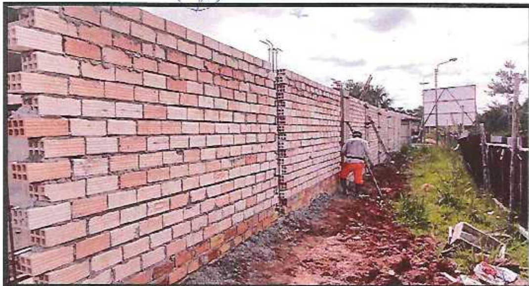
Muro de ladrillo tipo sogá en cerco perimetrico
